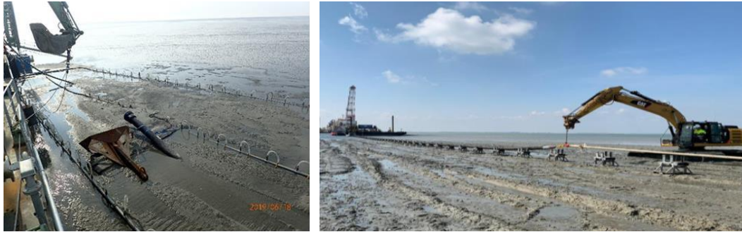
Figuur 10 Links: uittredepunt HDD, rechts: kabel wordt met rupskraan op rollers gebracht
